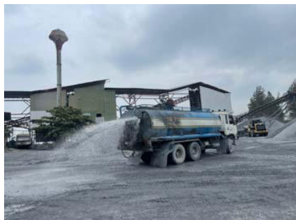
รูปที่ 2-8: การฉีดพรมน้ำบริเวณโรงโม่หินของโครงการ
